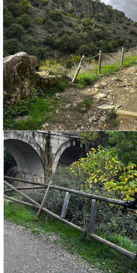
Además, el terreno presenta problemas significativos de erosión, especialmente en épocas de lluvia, cuando el agua de escorrentía causa la formación de surcos, baches y zonas desniveladas que dificultan el tránsito y representan un riesgo para los usuarios. La ausencia de un sistema efectivo de canalización de aguas pluviales exacerba este problema, ya que la pendiente natural del terreno intensifica el impacto del agua sobre la superficie del sendero.
